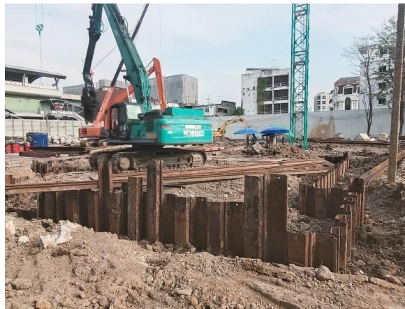
รูปที่ 63 การลง Sheet pile
